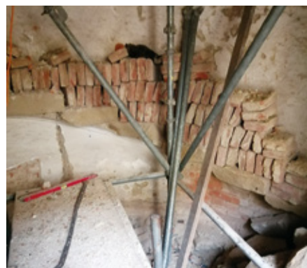
Výťahová šachta • Foto: 2x archiv MÚ
