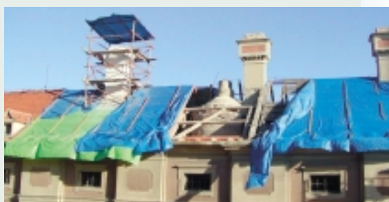
Pohled na odkrytou střechu severního křídla. Mezi krovy je vidět zděná šachta točitého schodiště, které propojuje všechna tři nadzemní podlaží a půdní prostor.
