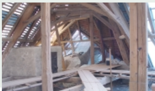
Pohled na odkrytou střechu severního křídla. Mezi krovy je vidět zděná šachta točitého schodiště, které propojuje všechna tři nadzemní podlaží a půdní prostor.
