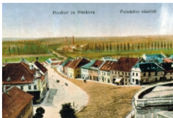
Pohled na Palackého nám. před stavbou Společenského domu (mezi léty 1903–1906). Foto ze sbírek HM
