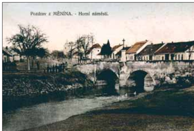
Měnin – pohled na náves a most přes Cézavu – poč. 20. stol.
