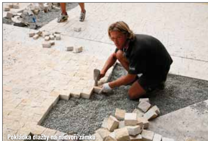
Pokládka dlažby na nádvoří zámku
