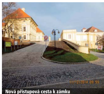
Nová přístupová cesta k zámku
