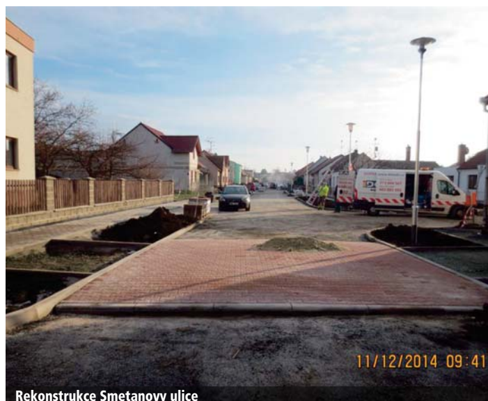
Rekonstrukce Smetanovy ulice
