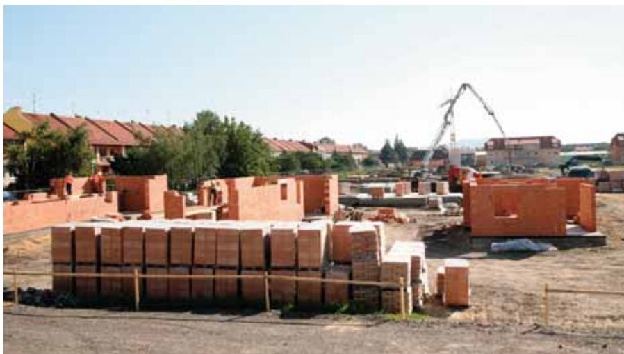
Staveniště ve Slovákove ulici
