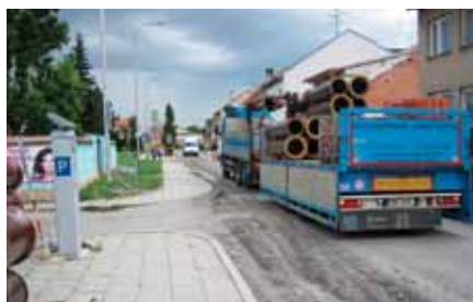
Oprava kanalizace v ulici Boženy Němcové
