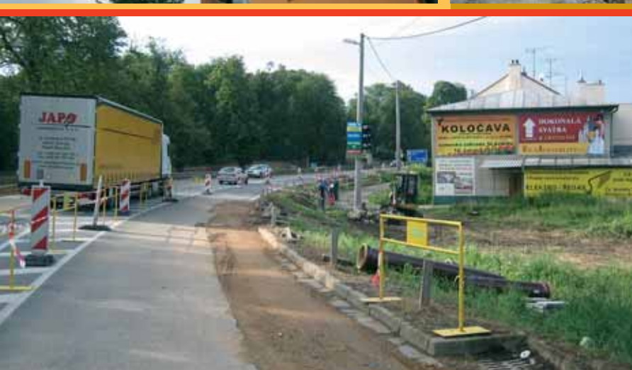
Stavba protihlukové stěny v ulici Čs. červeného kříže
