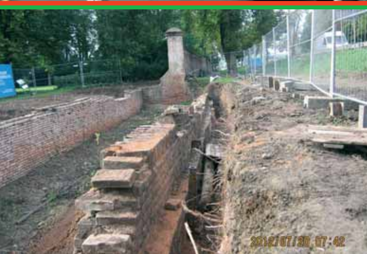
Oprava vodního příkopu u zámeckého parku
