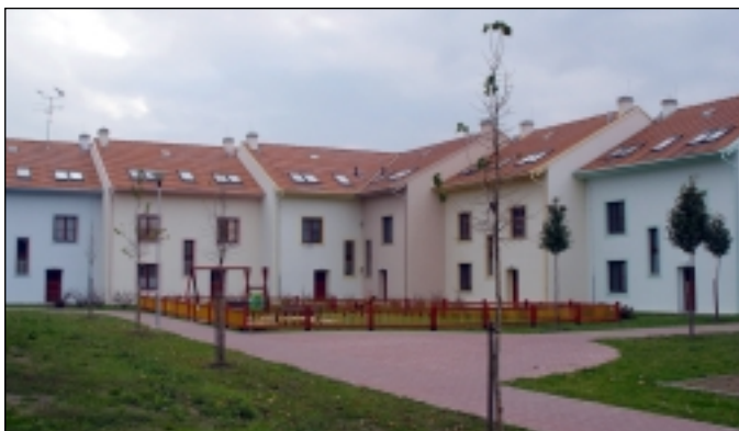
Na Litavské ulici byla oplocena plocha stávajícího pískoviště
