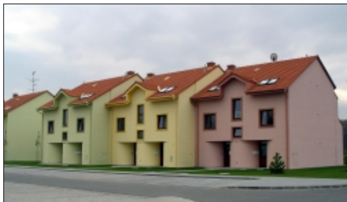
Tři předané bytové domy v ulici Litavská
