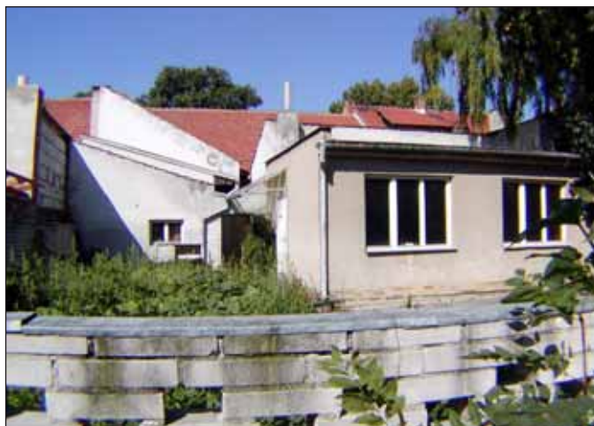
Zvláštní škola, pohled ze dvora.
