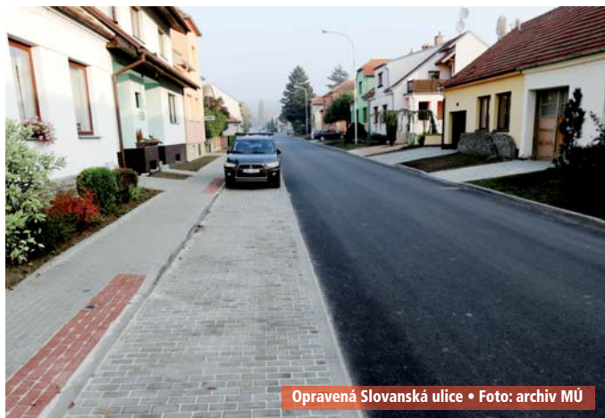
Oprava chodníků v Sušilově ulici • Foto: archiv MÚ
