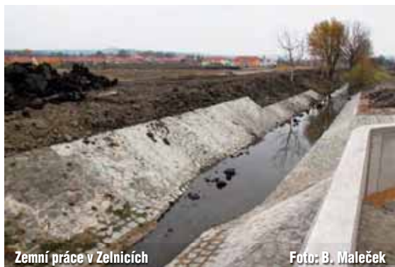
Zemní práce v Zelnicích
