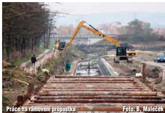
Práce na rámovém propustku
