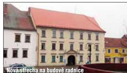
Nová střecha na budově radnice
