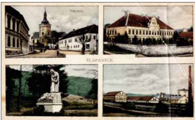
Šlapanice – významné budovy obce – 1. pol. 20. století
