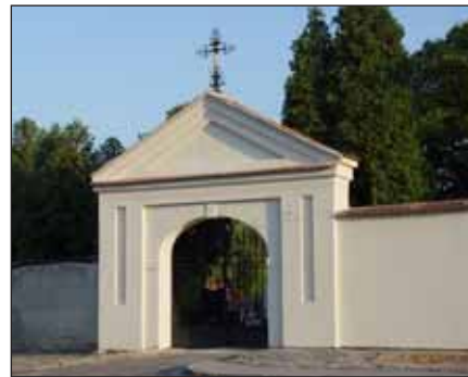
Rekonstrukce hřbitovní brány.
