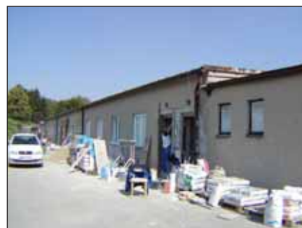
Kabiny na stadionu.
