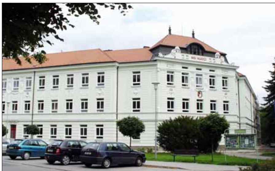
Oprava fasády ZŠ Komenského.
