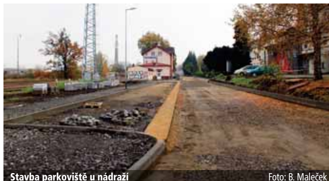
Stavba parkoviště u nádraží
